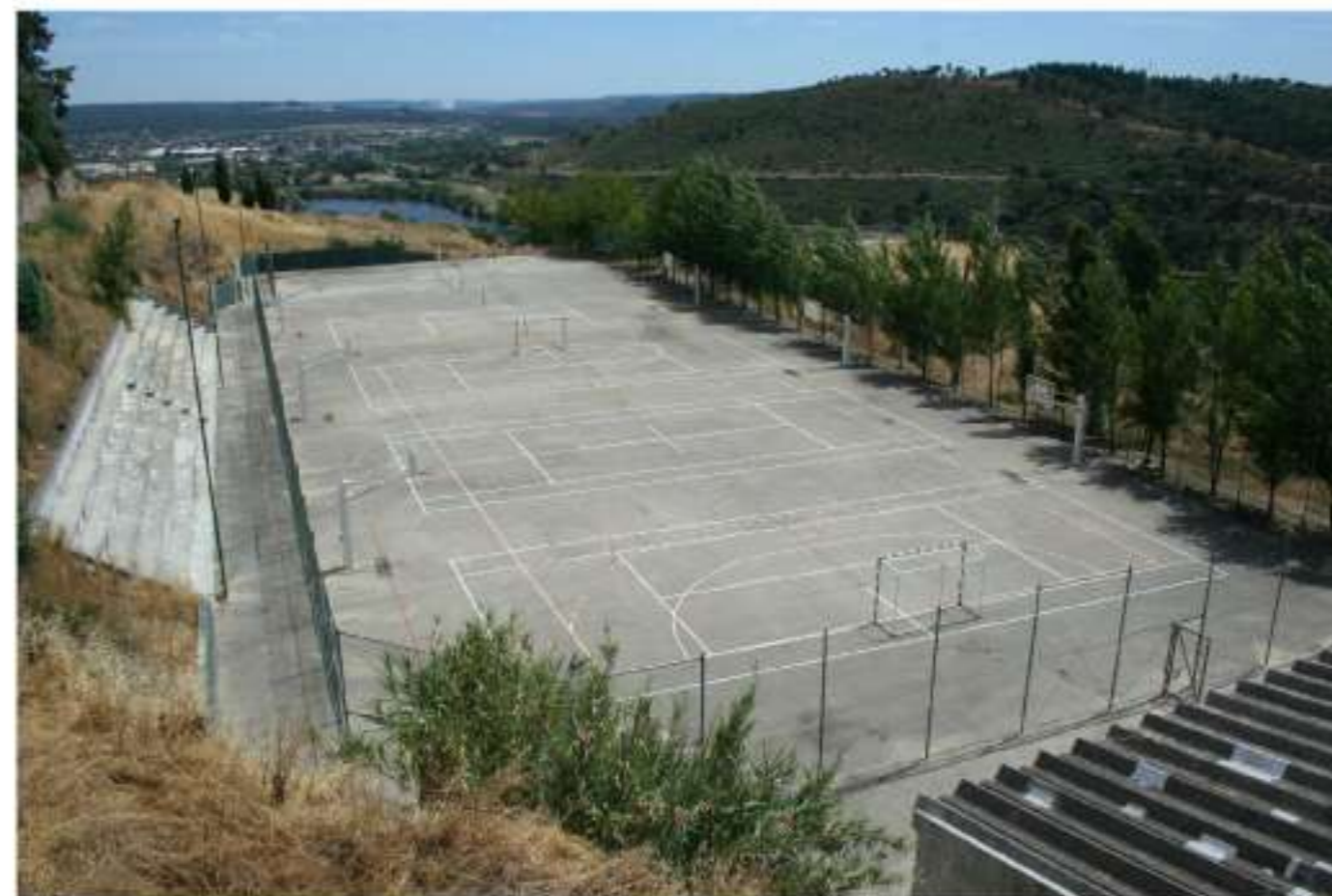
ÁREA DESPORTIVA EXTERIOR A RECUPERAR
