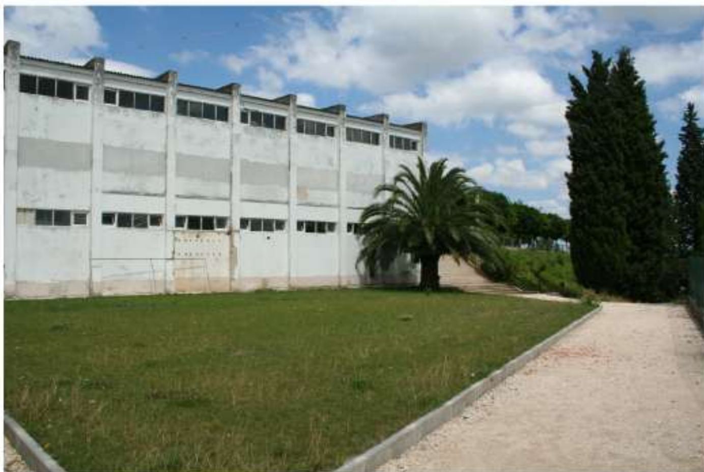
POLIDESPORTIVO A DEMOLIR
